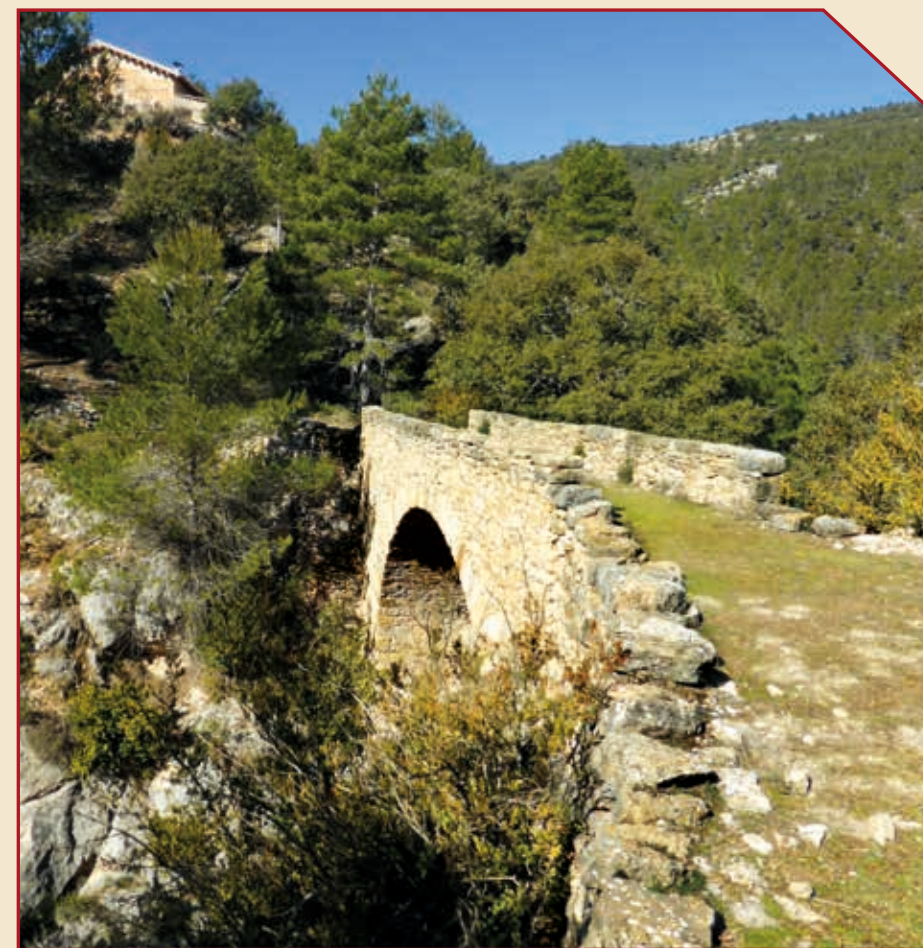
// Puente de La Canaleta.
