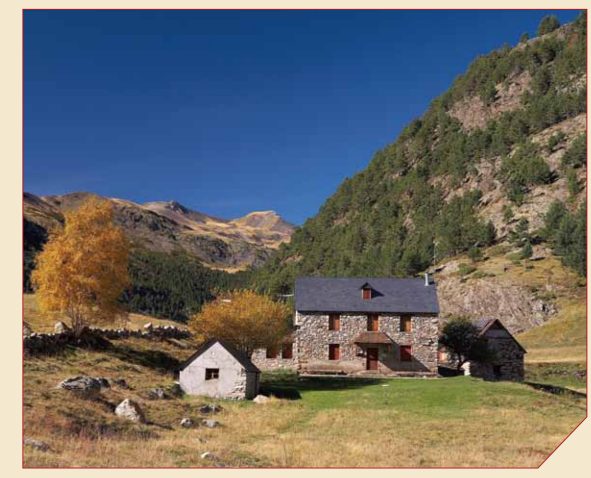
// Refugio de Viadós
